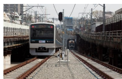
梅ヶ丘駅側取付部
