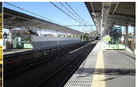
ホーム延伸工事中の黒川駅
