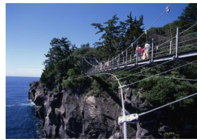
「城ヶ崎海岸の門脇つり橋」
