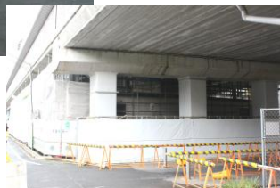
「小田急クローゼット成城」外観と、同施設に隣接する高架下に建設中の「小田急クローゼット成城B棟」外観
