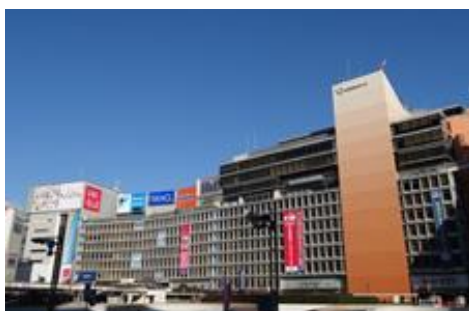
熱源システム更新を行った新宿西口駅本屋ビル
