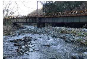
第2四十八瀬川橋梁 (渋沢駅～新松田間駅間)
