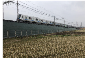
改修後の法面
