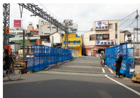
地下化に伴い廃止となった 東北沢6号踏切
