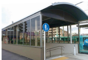
踏切を廃止し整備された 向ヶ丘遊園駅連絡通路
