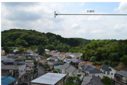
地点④ 長尾配水塔跡地付近
