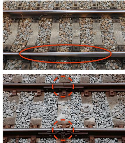
伸縮継目(写真上)と従来の継目(写真下)
