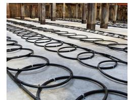
ホーム階の一部のエアコンは、地中にホースを埋め込み年間を通して15℃と一定している地中の温度を活用し、約30% CO<sub>2</sub> 排出量を削減しています。
