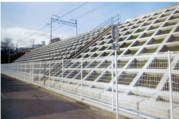
法面防護工事
