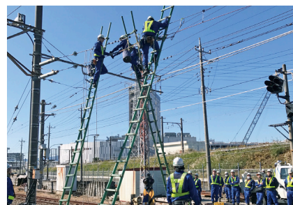
電気設備復旧訓練
