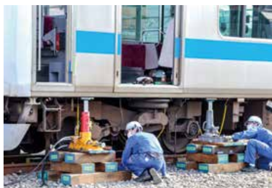
車両脱線復旧訓練
