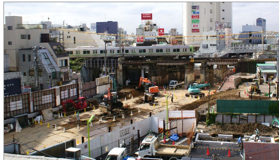
下北沢駅旧駅舎の解体(2013年9月完了)
