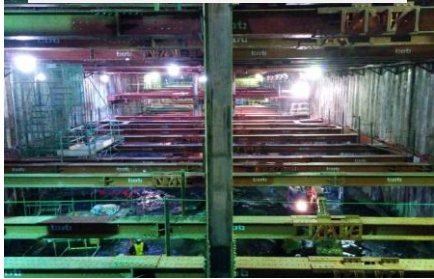
緩行線トンネル構築工事
