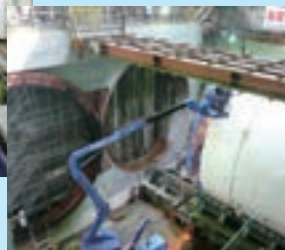
シールドトンネル工事
