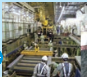
駅ホーム部線路用 仮橋の設置工事
