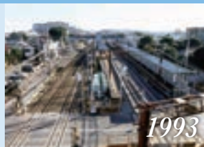
(10月) 仮線工事が完了
