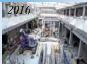
(4月) 下北沢駅舎内部の工事の様子
