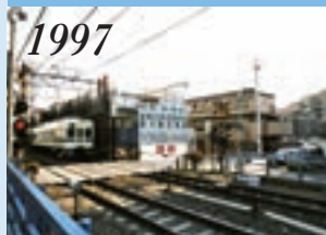
経堂～千歳船橋間での高架橋建設工事
