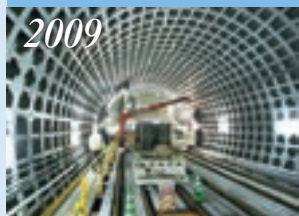
シールドマシン掘進時
