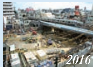
京王井の頭線橋梁架設工事
