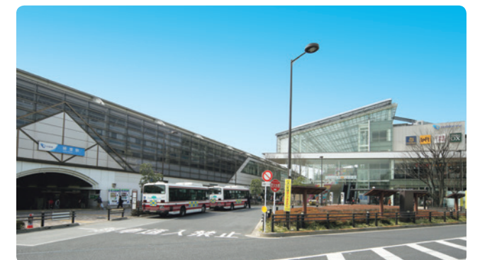
複々線化事業により線路が高架化され、整備された経堂駅前広場
