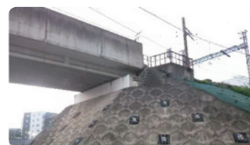
耐震補強 (境川)
