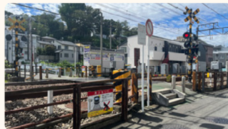
集中監視システムを導入した踏切
