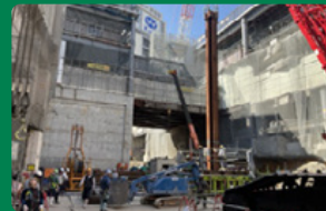
工事が進む新築建物(A区)
