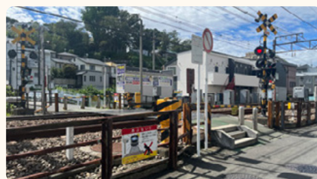
集中監視システムを導入した踏切
