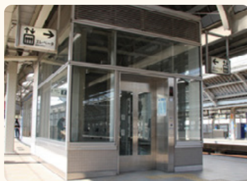
エレベーター
