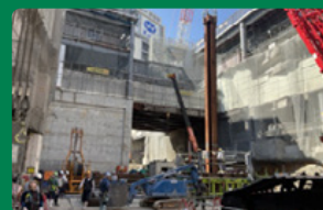
工事が進む新築建物(A区)
