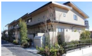
2016年1月 リーシア代田テラス完成
