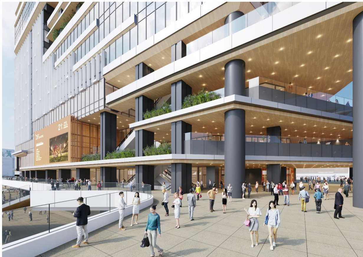
2階・東西デッキ グランドシャフト
