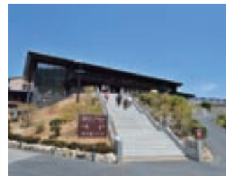
本年4月に使用を開始した大涌谷新駅舎
