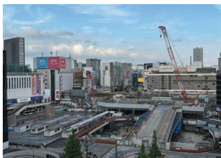
新宿駅西口地区開発計画における工事の様子
