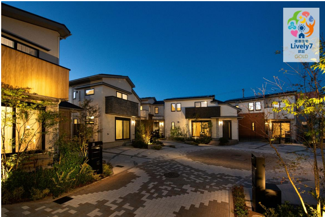
リーフィア狛江 蒼翠の街 街区中央のクルドサック(夜景)
