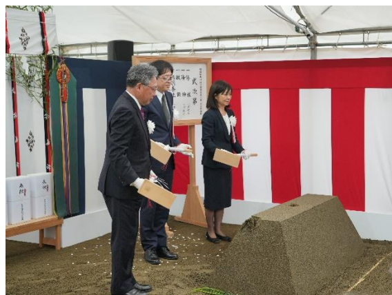
新築着工（安全祈願祭）の様子
