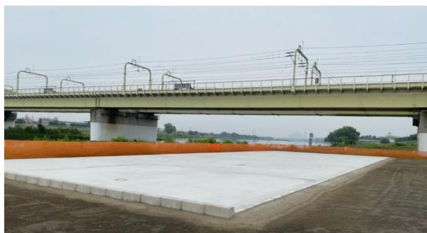
コンクリート舗装の広場
