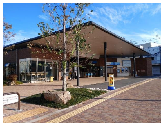
2017年3月に完成した世田谷代田駅舎
