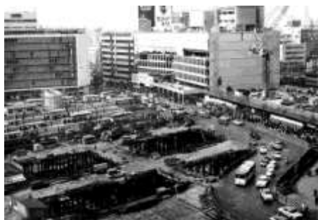
新宿駅西口の建設風景(1964年頃)
