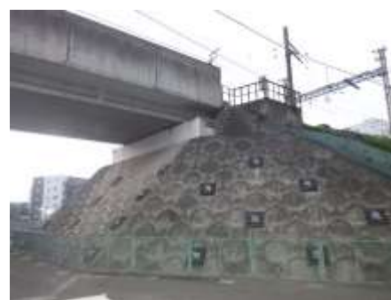
境川橋梁の耐震補強
