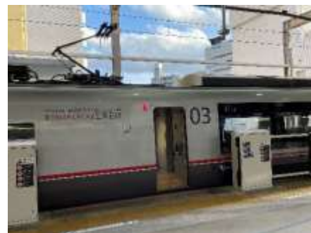
大開口ホームドア（本厚木駅）
