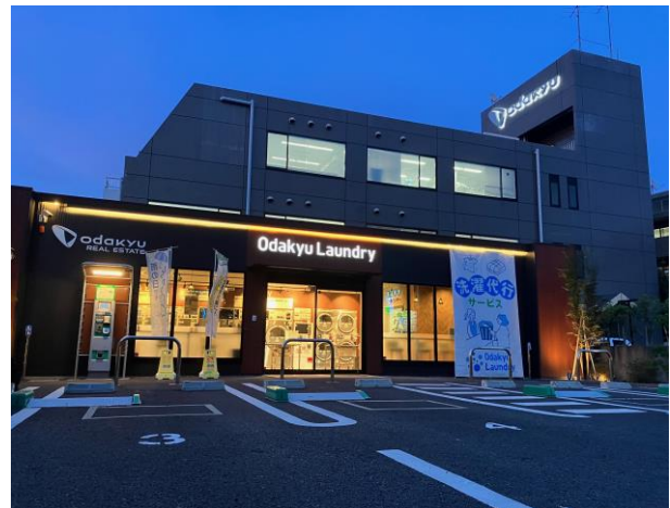
Odakyu Laundry 経堂店 夜間外観
