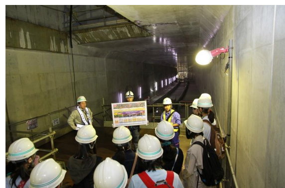
複々線化工事区間の見学
