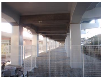
耐震補強工事（高架橋）※イメージ
