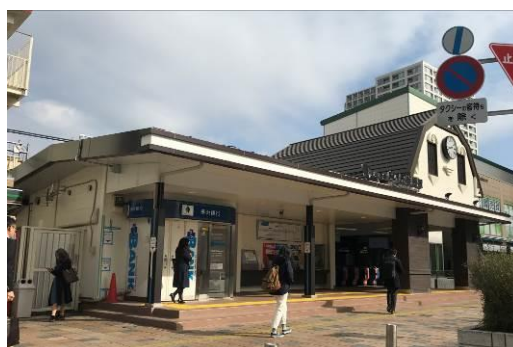
南口外観(施工後)
