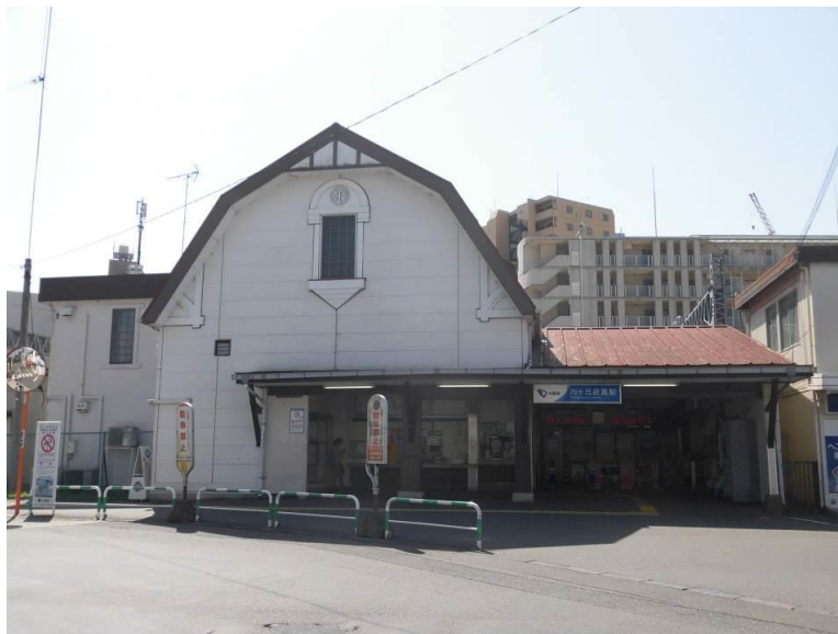
2019年度の改良を予定するマンサード屋根を有する向ヶ丘遊園駅北口駅舎
