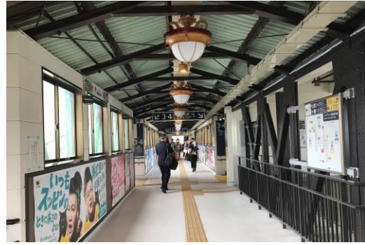
跨線橋部(施工後)
