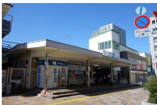
南口外観(施工前)
