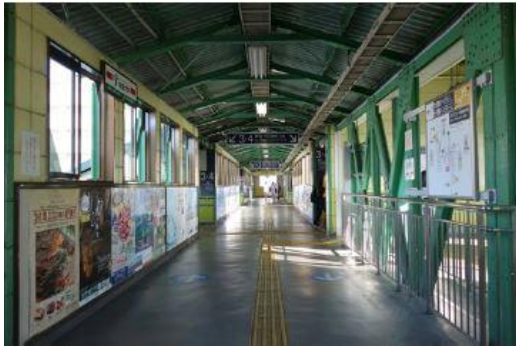
跨線橋部(施工前)
