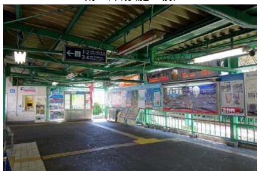
南口内観(施工前)
