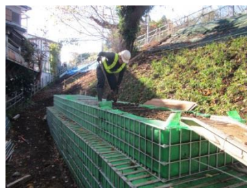
法面改修工事
