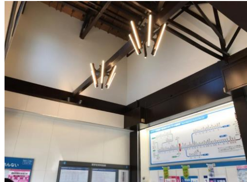
コンコース（施工後）
