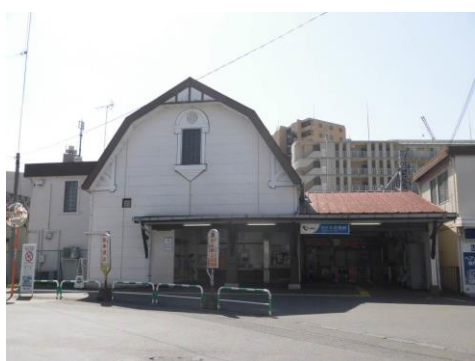
北口外観（施工前）
