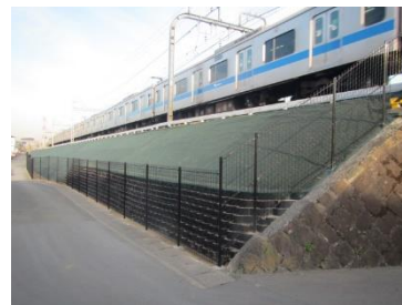
改修後の法面の様子
