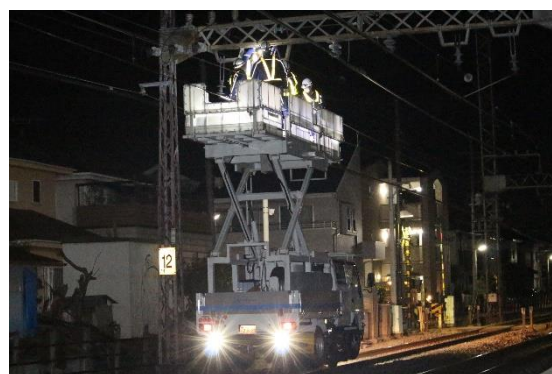
軌陸車にて電気保守作業を行っている様子
