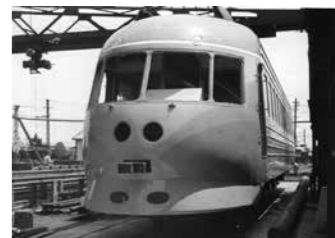
日本車輛製造工場場で建造中の3000形。モノコック構造を採用し、普通鋼だが軽量化を実現した
