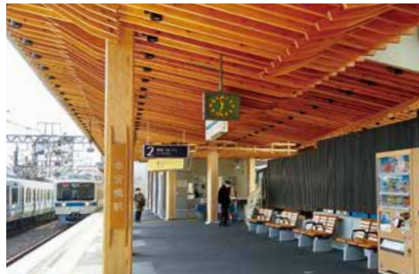
「垂木」「向拝柱」をイメージしたホーム
