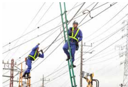
設備復旧訓練 (電気部)
