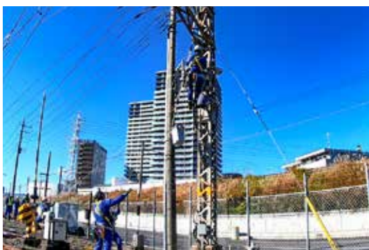
技術競技会 (電気部)
